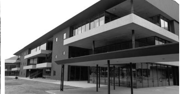
講義棟 / 令和7年3月完成
